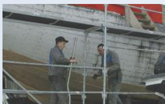
Les chaudronniers à l'ouvrage
