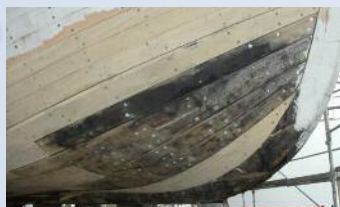
Une grande partie des bordés a été remplacée
