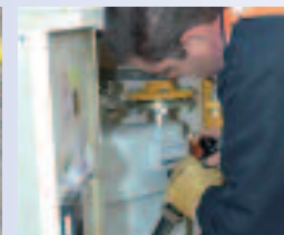
Raccordement du poste gaz
