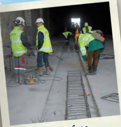
le coulage des longrines
