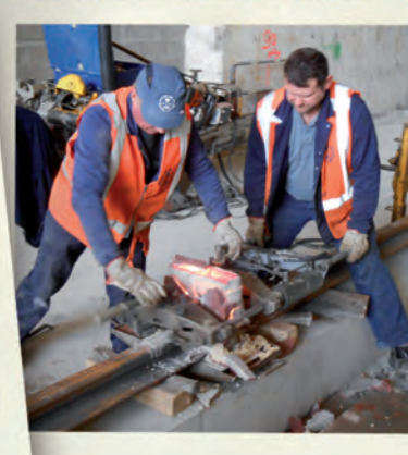
la pose des rails
