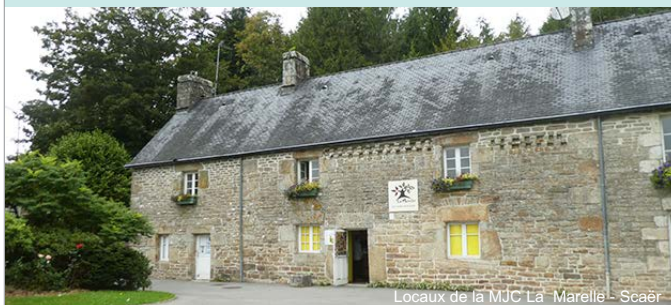
Locaux de la MJC La Marelle - Scaër
