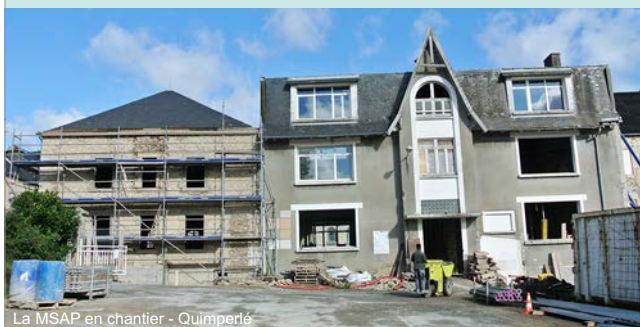
La MSAP en chantier - Quimperlé
