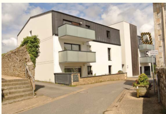
Aménagement des accès piétons avec création de passages et d'escaliers
